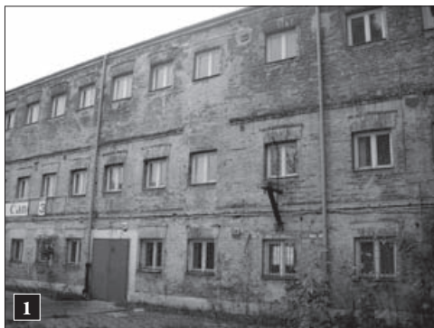
1 Budynek produkcyjny. Stan z 2006 r.
