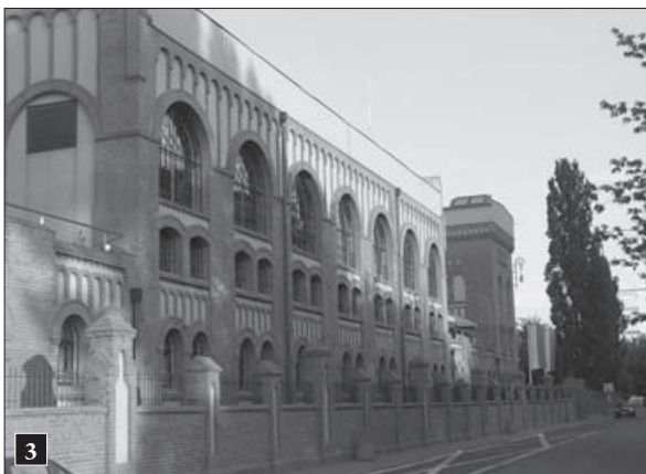
3 Widok od ul. Przyokopowej. Stan z 2009 r.
