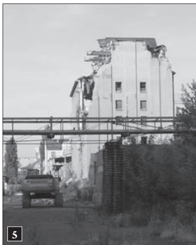
5 Warzelnia, widok od strony zachodniej. Stan z 2009 r.
