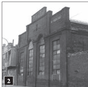
2 Odlewnia, elewacja od ulicy. Zdjęcie archiwalne z 1983 r.
